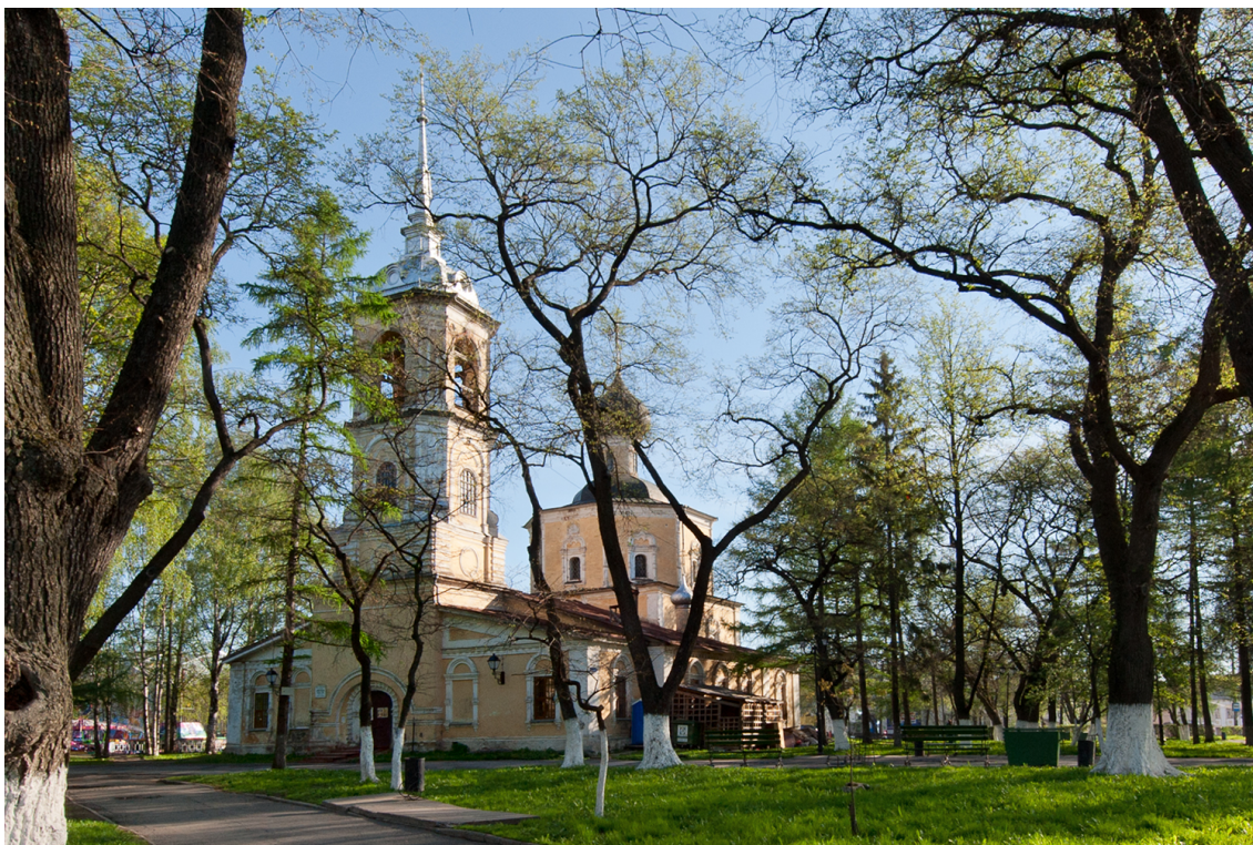
Рис. 1. Церковь Усекновения главы Иоанна Предтечи в Рощенье г.Вологды. Вид с юго-запада.
